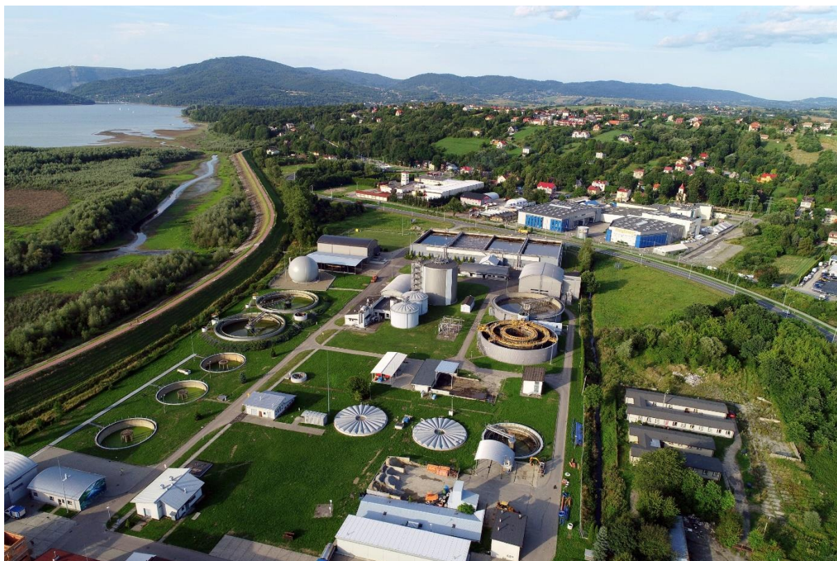
Rysunek 20. Oczyszczalnia ścieków w Żywcu
