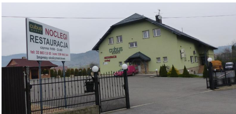
Istniejąca restauracja w rejonie ulicy Handlowej - w planie jako teren usługowy U
