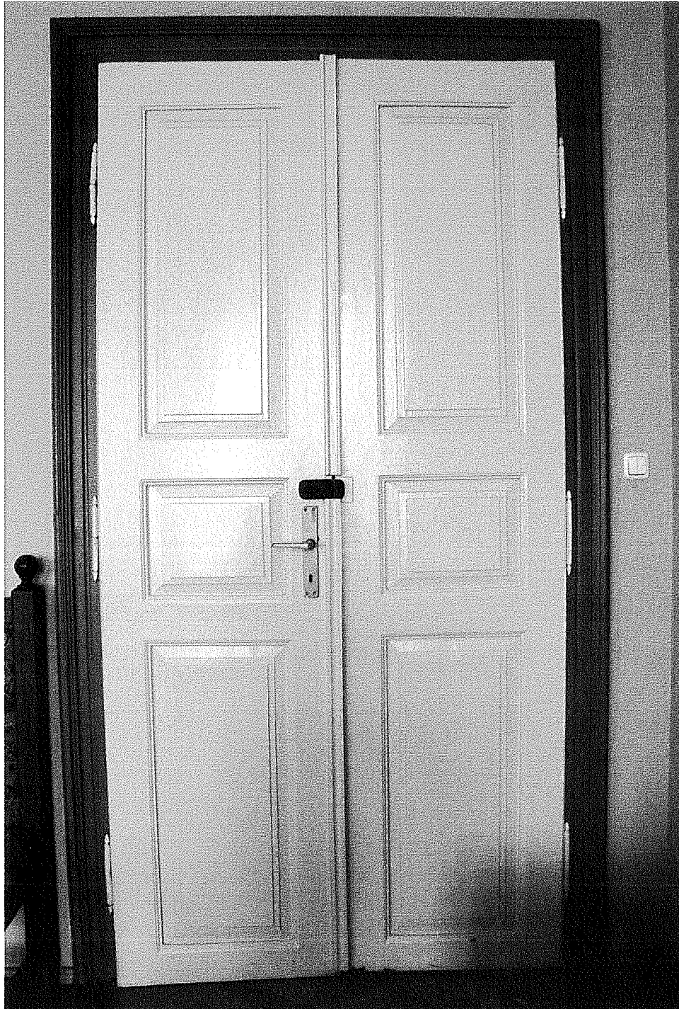
ZACHOWANA STOLARKA DRZWIOWA
