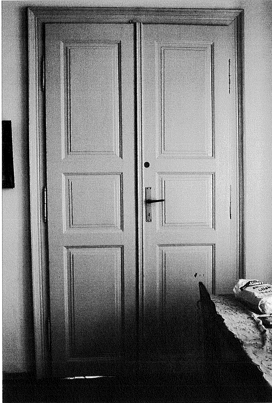
ZACHOWANA STOLARKA DRZWIOWA
