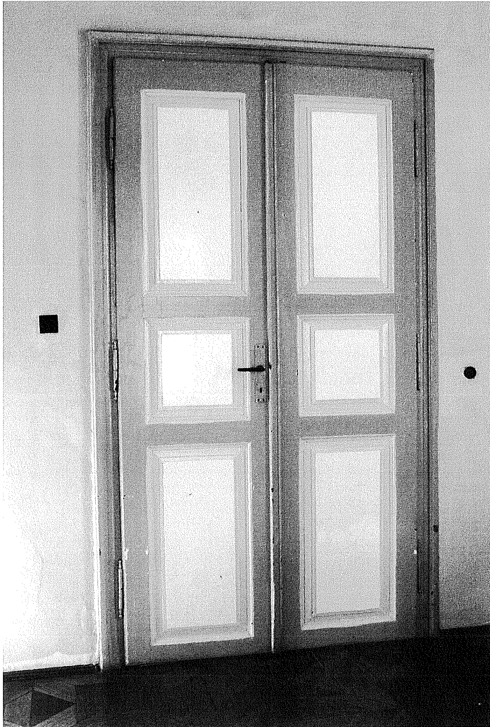
ZACHOWANA STOLARKA DRZWIOWA
