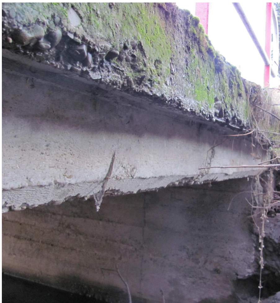
Fot. 3 Konstrukcja nośna, podpora prawa
