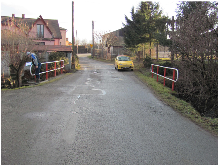
Fot. 1 Widok ogólny na most
