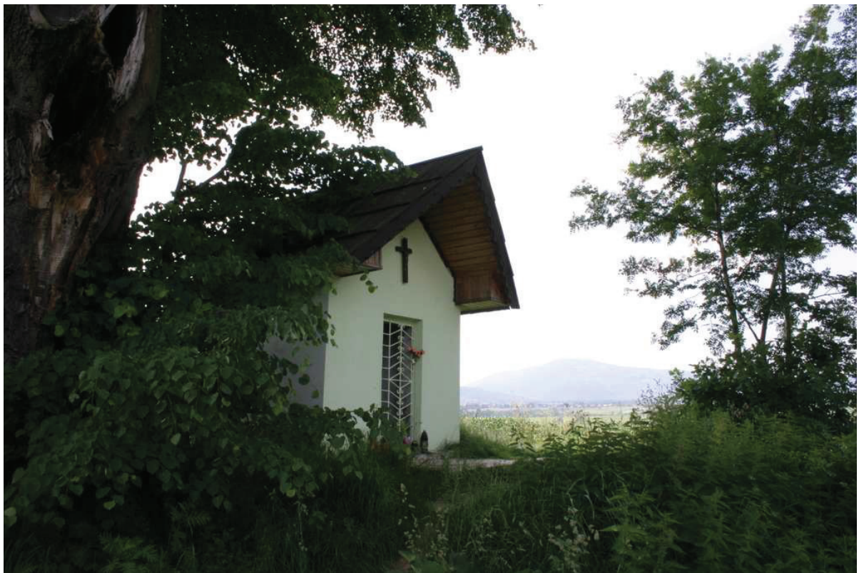
Widok z drogi, widoczne we fragmencie drzewo zagrażające kapliczce
