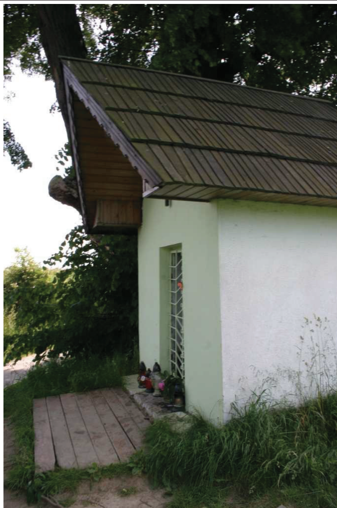
Widok na wejście, przed kapliczką drewniany podest przeznaczony do demontażu
