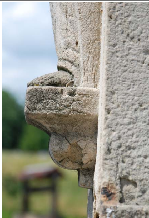
Zabrudzenia, rozwarstwienia, zatarte zdobienia i płaskorzeźby
