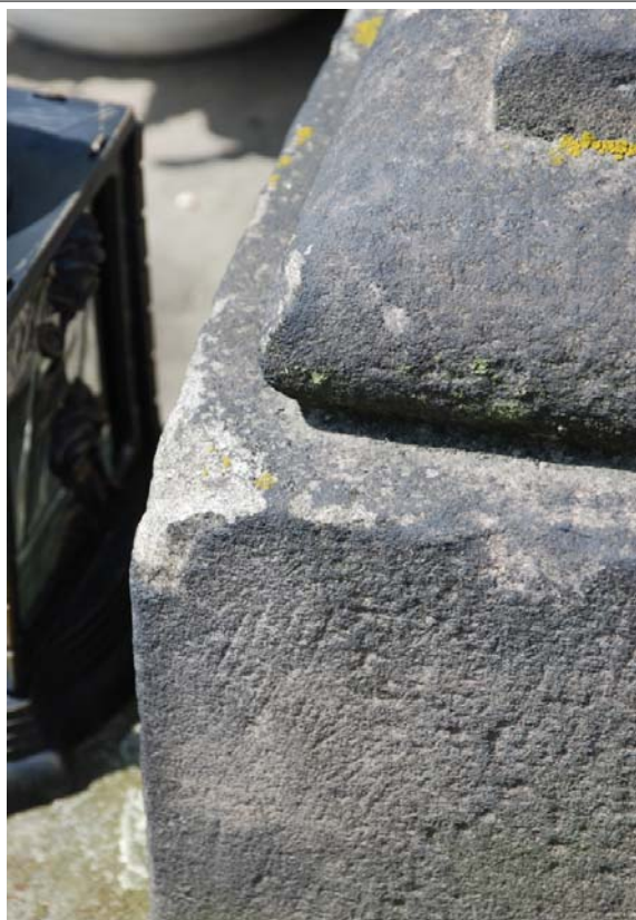
Odspojenia i ubytki kamienia
