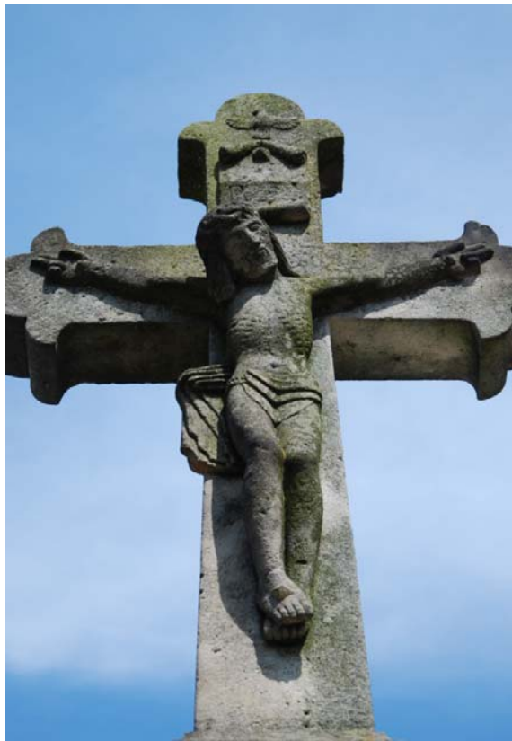
Płaskorzeźba i krzyż. Rozwarstwienia i odspojenia oraz zielone fragmenty kamienia
