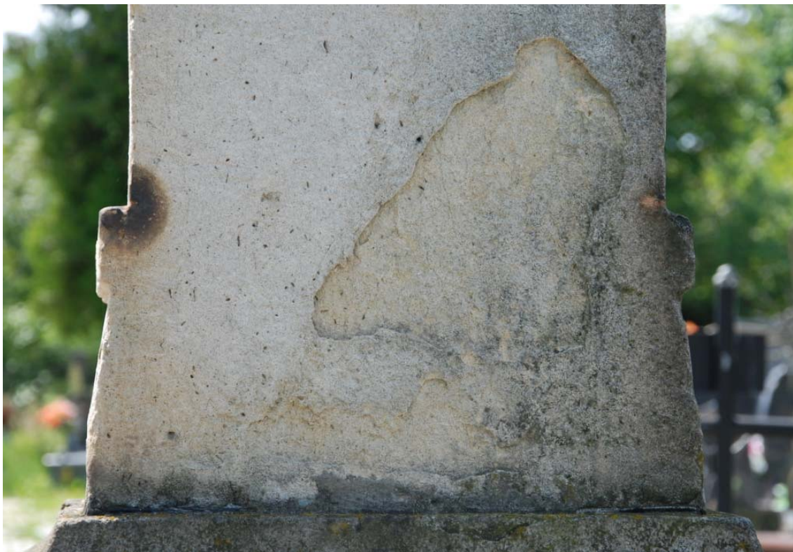
Płaskorzeźba i krzyż. Rozwarstwienia i odspojenia oraz zielone fragmenty kamienia
