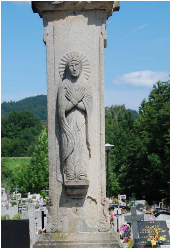
Płaskorzeźba i krzyż. Rozwarstwienia i odspojenia oraz zielone fragmenty kamienia
