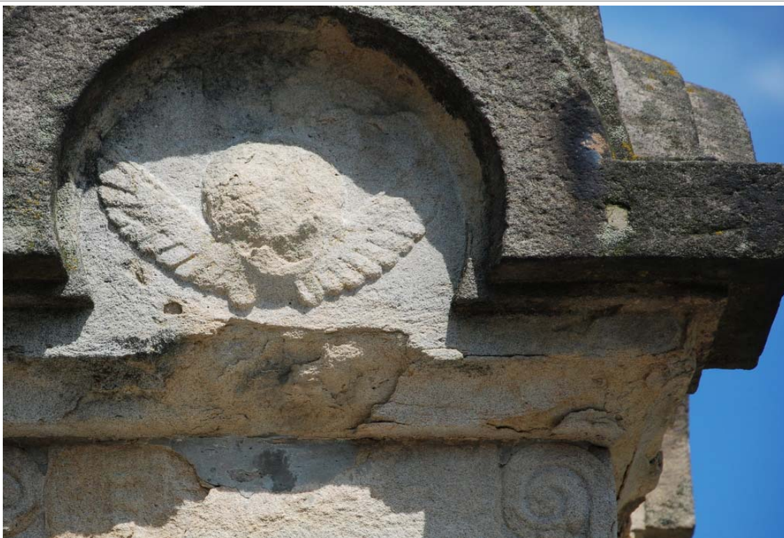
Zabrudzenia, rozwarstwienia, zatarte zdobienia i płaskorzeźby
