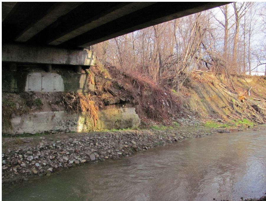
Fot. 8 Koryto potoku – widok w stronę dolnej wody.
