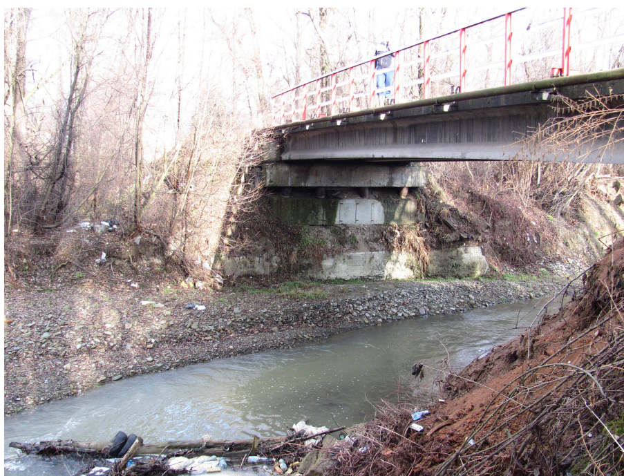
Fot. 2 Widok na most od strony górnej wody
