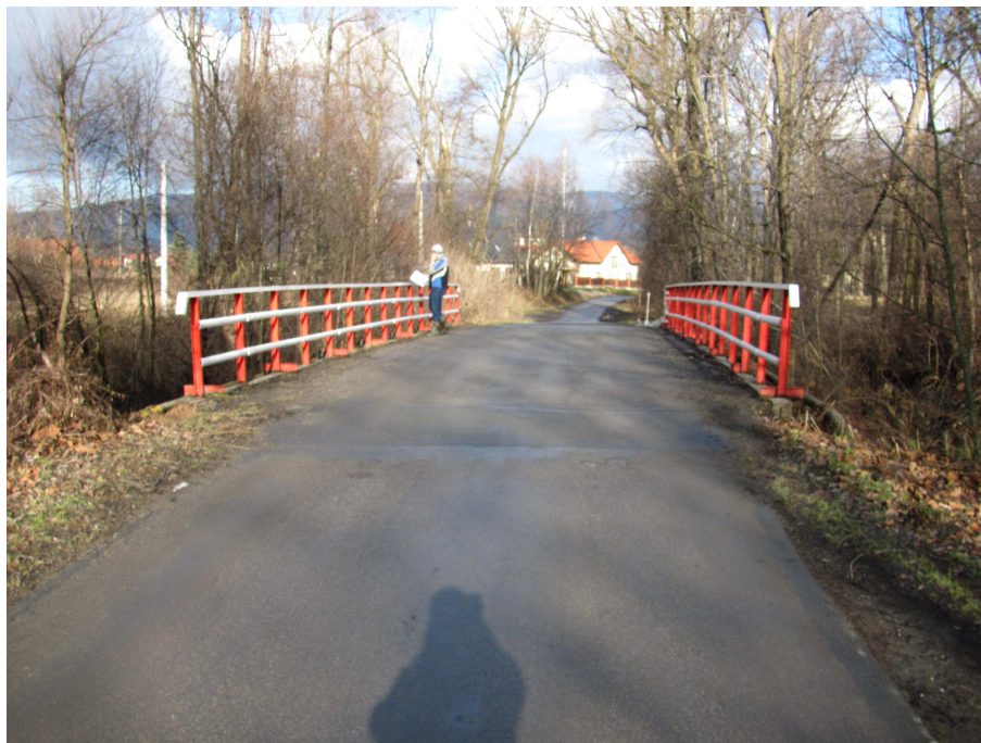
Fot. 1 Widok ogólny na most
