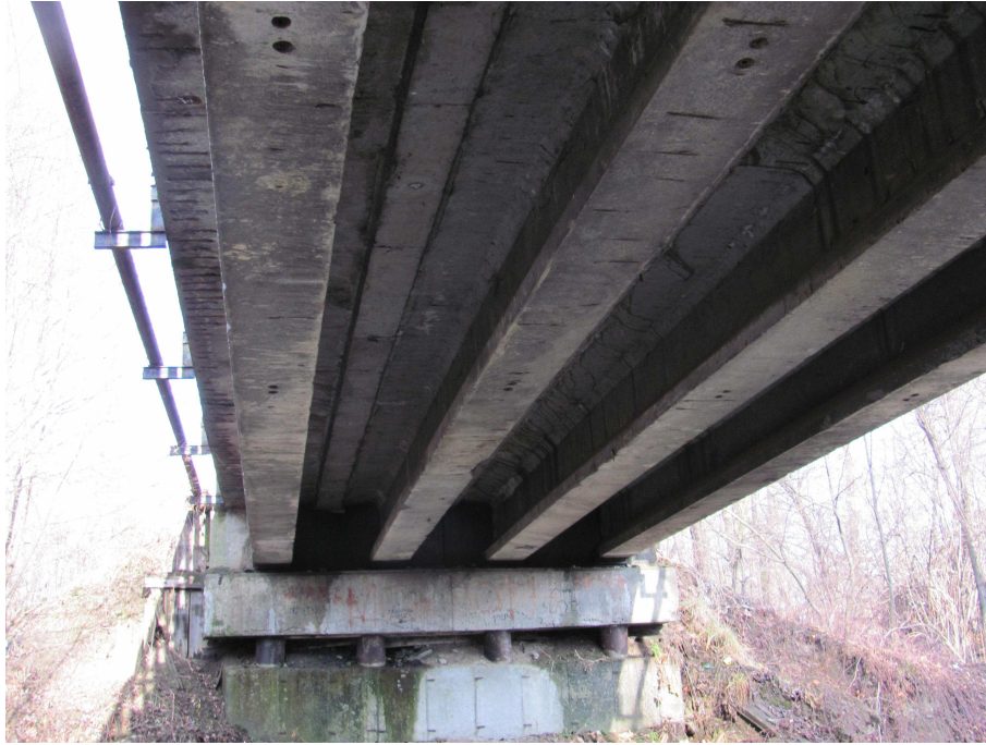
Fot. 3 Konstrukcja nośna, podpora lewa
