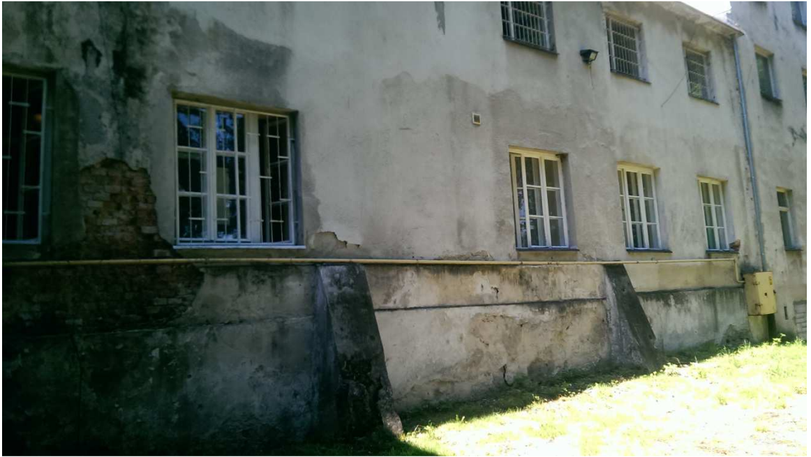
Foto6. Przypery fundamentowe, kamienne:
