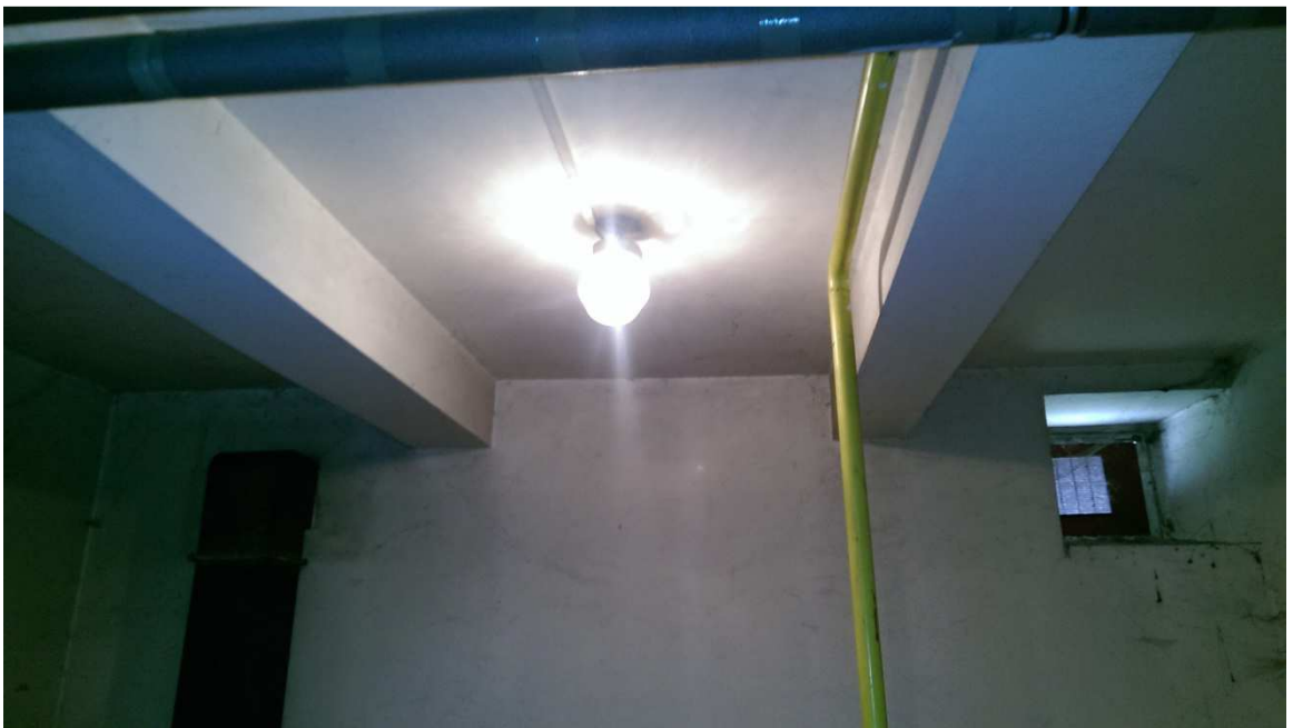
Foto7. Konstrukcja stropu żelbetowego nad piwnicą:
