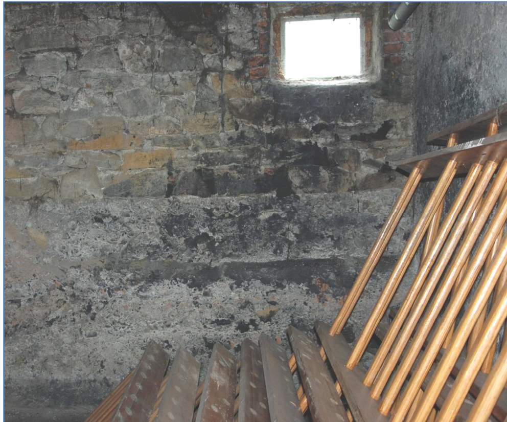
[Fot. 2] Ściany fundamentowe w piwnicy
