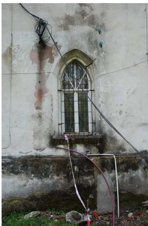
[Fot. 3] Stan techniczny ścian parteru
