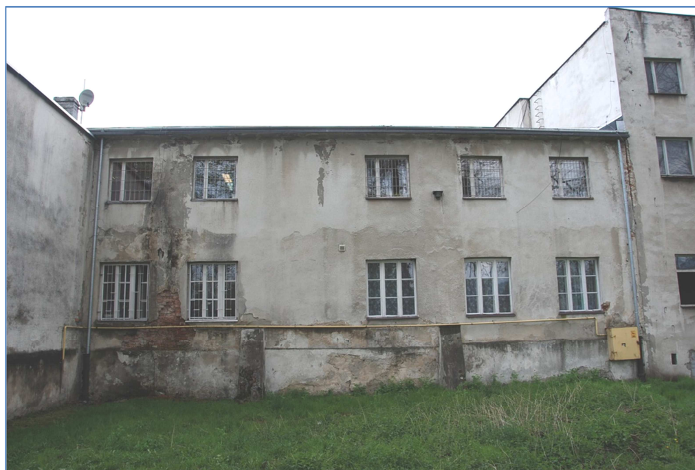
[Fot. 1] Widok budynku segmentu „B1”
