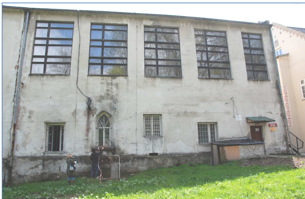
[Fot. 1] Widok budynku segmentu „B2”
