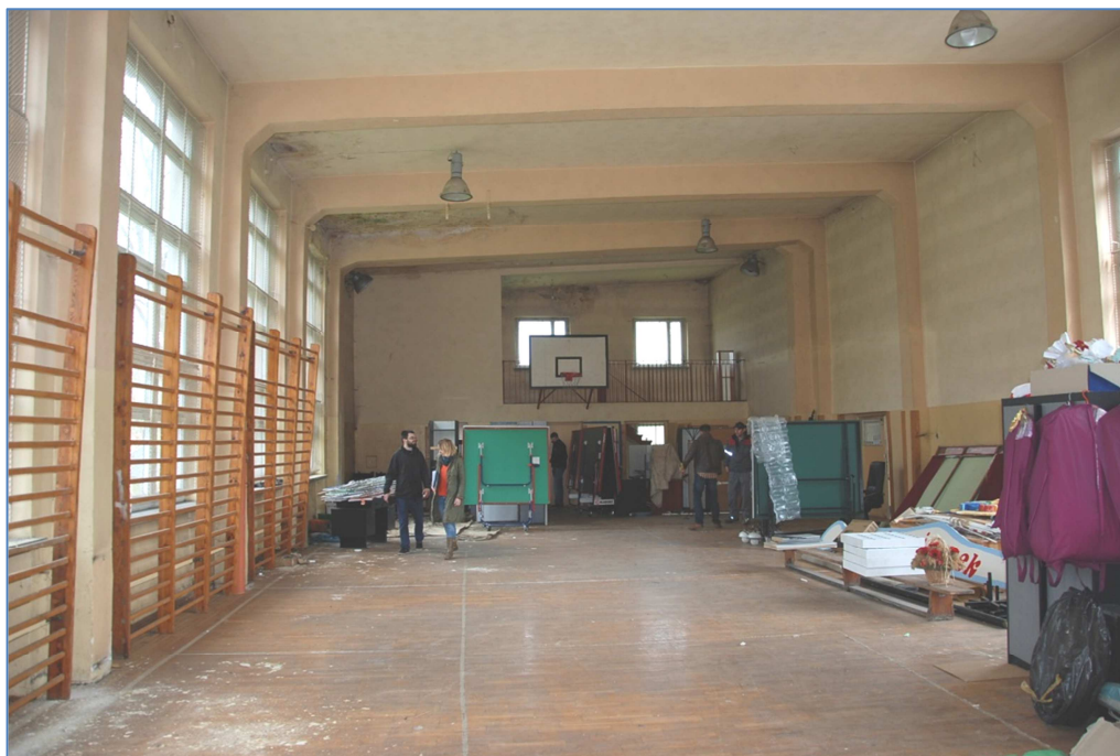
[Fot. 2] Konstrukcja Sali gimnastycznej
