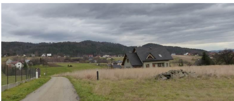
Miejscami zabudowa jest silnie rozproszona, pojedyncze domy powstają wśród otwartych pól, co wymusza realizację nowych dróg dojazdowych i sieci infrastruktury technicznej.
